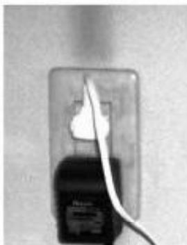
落雷で大きな電流が流れ込んだ住宅。コンセント周辺が黒くすすけている。—光産業提供
