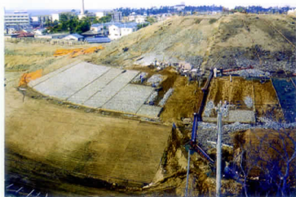
後円部の復元工事
