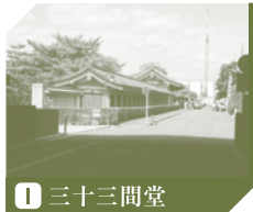
D 三十三間堂 正式名は蓮華王院といわれ、当時の工夫を凝らした「揺れ動く建築物」としての免震工法が施されています。
