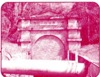
放水門 明治38年竣工の(立ヶ畑堰堤)登録有形文化財文字の左右に「石うす」を埋めこんでいます
