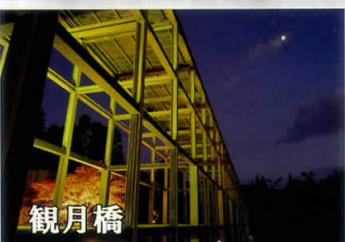
観月橋 中秋の名月が登る道に沿って架かった歩廊橋。橋から庭園内を一望できます。 *延長123m、水面上約10m、幅4m
