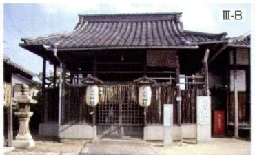
1 1 関大明神社 平安時代に西下する貴族や官人がここで別れを惜んだ地。本殿は室町中期に造立され、大阪府指定文化財となっている。
