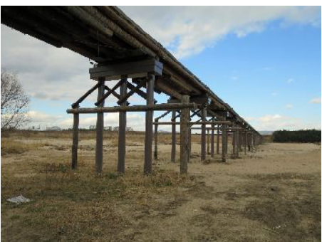
上津屋橋(流れ橋)
