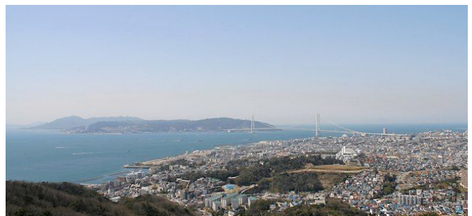
淡路島、明石海峡、明石海峡大橋を望む
