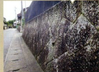
職人の技でつくられた石垣
